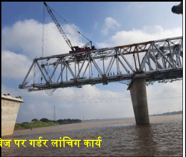
रेवाड़ी-दादरी खंड पर वायडक्ट-92 पर गर्डर लांचिंग का कार्य प्रगति पर
