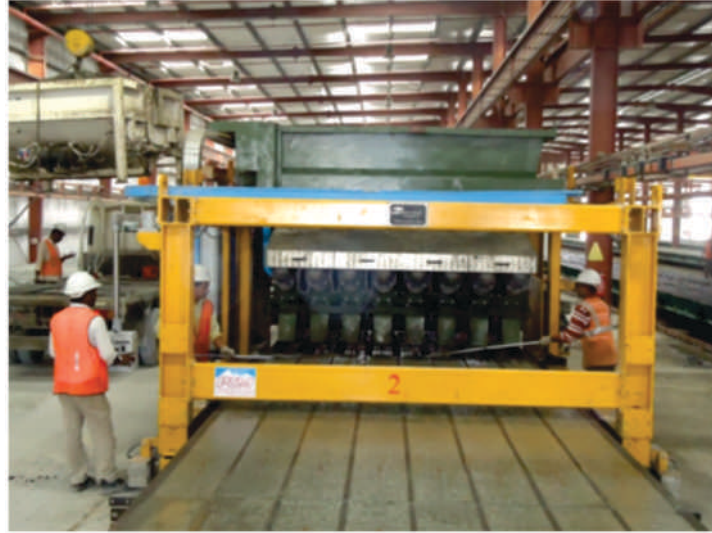
लॉन्ग लाइन स्लीपर कास्टिंग प्लान्ट भगेगा-प.डीएफसी
