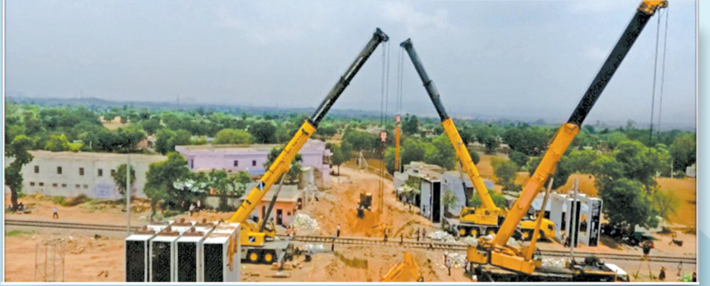
पश्चिमी डीएफसी के रेवाड़ी-इकबालगढ़ सेक्शन में चल रहा निर्माण कार्य
