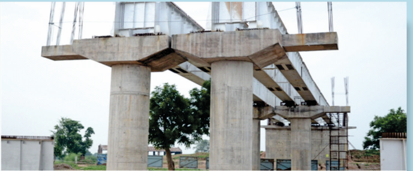
पूर्वी डीएफसी में टूंडला के पास मेजर ब्रिज का निर्माण कार्य प्रगति पर
