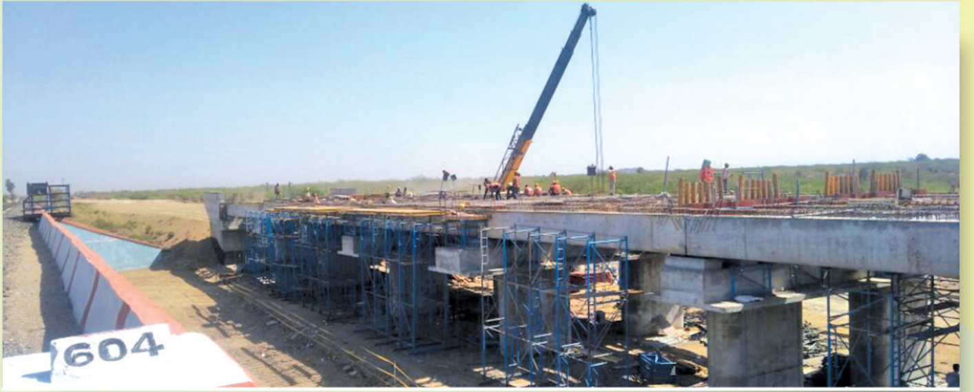
पश्चिमी डीएफसी के ब्रिज संख्या 831 पर सब स्ट्रक्चर का कार्य प्रगति पर
