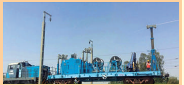
ईडीएफसी - मैकेनाइज्ड वायरिंग ट्रेन के जरिए वायरिंग का कार्य प्रगति पर
