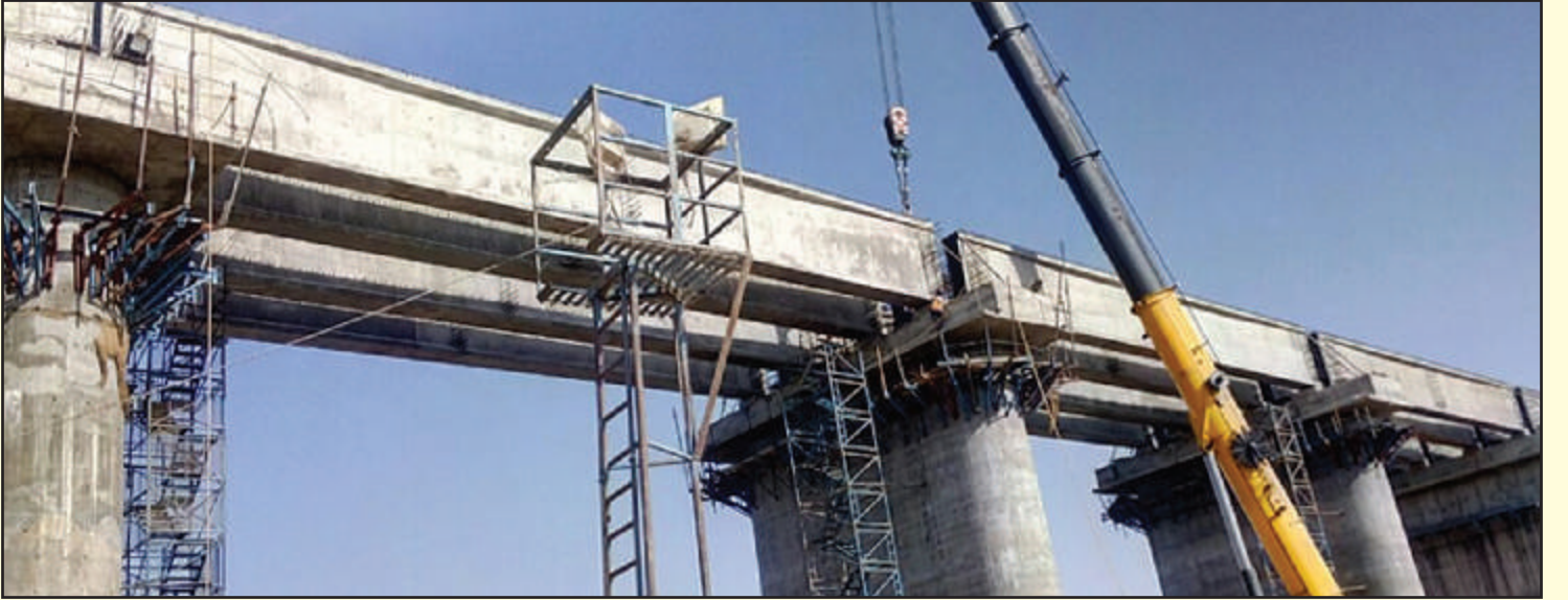
पश्चिमी डीएफसी – 676 बड़े पुल पर गर्डर्स का निर्माण प्रगति पर
